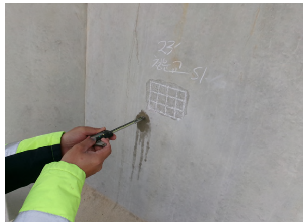
탄산화깊이 측정 현황
